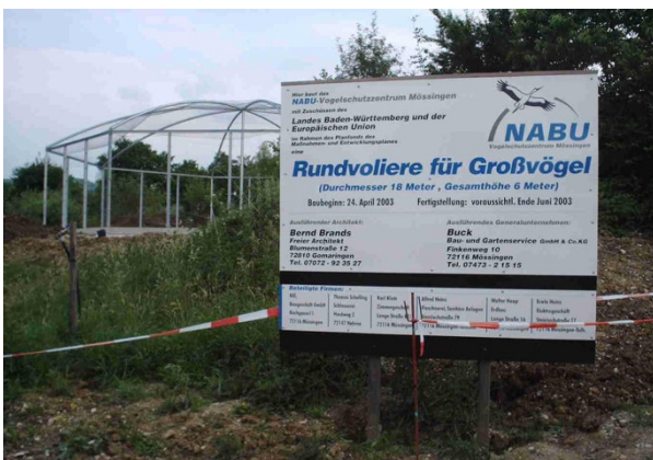
Baustelle der großen Rundvoliere mit Bauschild im Jahr 2003.
