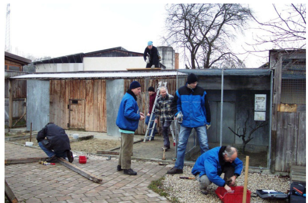
Abriss einer alten Voliere durch ehrenamtliche Helfer.
